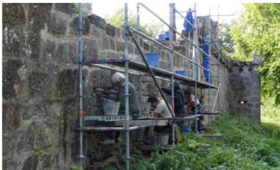
Jointement du rempart en septembre
